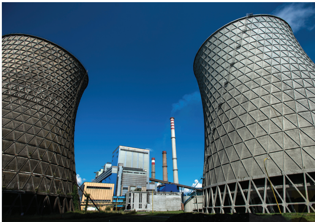
Termoelektrana u Tuzli ima okolišnu dozvolu koja joj omogućava prekomjerno zagađivanje. (Foto: CIN)
