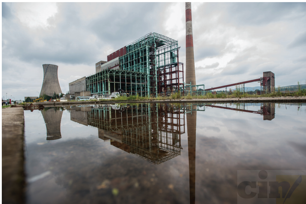
U vrijeme posjete novinara CIN-a Termoelektrana nije proizvodila struju zbog kvara uzrokovanog pucanjem jedne cijevi u kotlu. (Foto: CIN)
