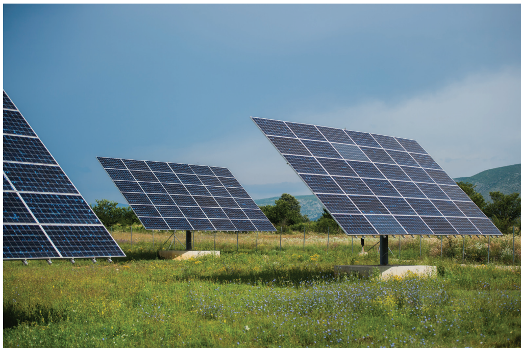
„Tomingovi“ solari se nalaze na betonskim stubovima i uz pomoć motora automatski se okreću prema suncu, tako proizvodeći više električne energije. (Foto: CIN)
